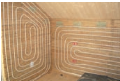
Wandheizung auf Schilfmatte mit Lehmputz (CTX 14 x 2)
