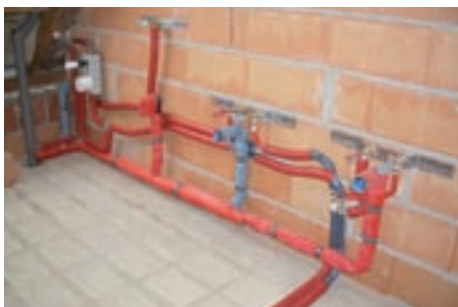
Sanitärinstallation (CTX 16 x 2 und 20 x 2)
