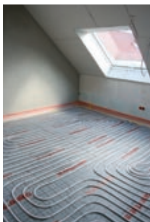
Fußbodenheizung/-kühlung mit Nassestrich (Wohnbereich, CTX 14 x 2)
