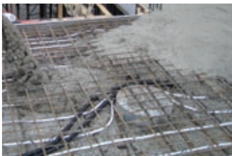
Betonkernaktivierung (Sparkassen-Versicherung, Ulm, CTX 16 x 2)
