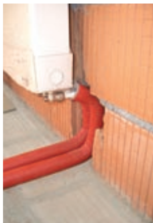
Heizkörperanbindung (z. B. CTX 14 x 2)
