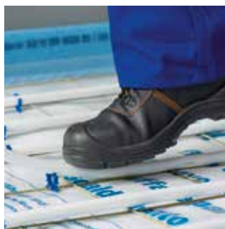
Następnie rury Uponor Comfort Pipe PLUS są wciskane w uchwyty do rur.
