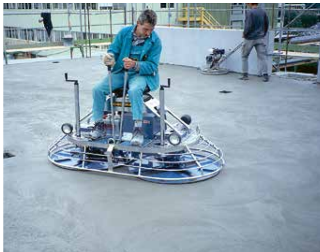
Wyglądanie powierzchni płyty betonowej
