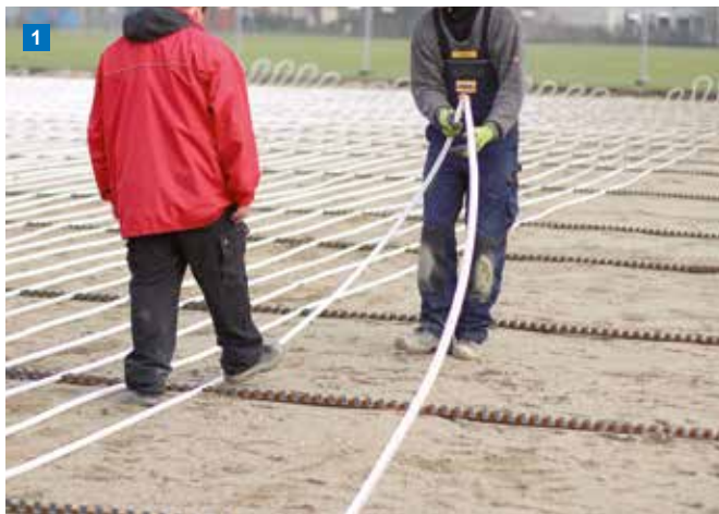
Na przygotowanym podłożu należy ułożyć szyny nośne oraz rury systemu Uponor Meltaway w obliczonym rozstawie.
