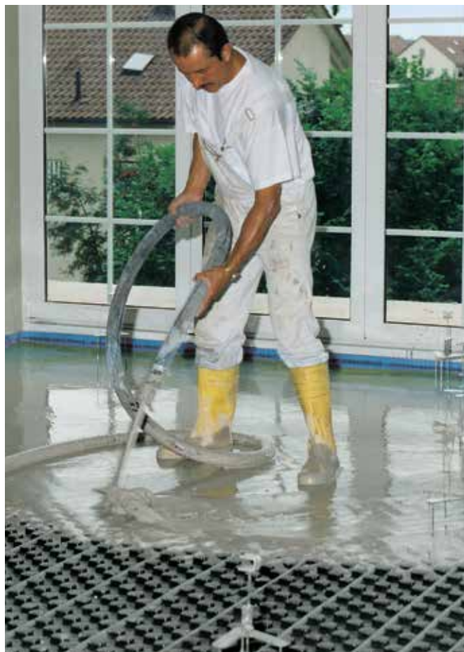
Wylewki samopoziomujące mogą być oparte na anhydrycie lub cemencie producenta.
